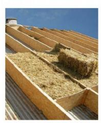
Il disposera les bottes de paille sur la surface correspondant à la zone grisée, pour créer une isolation de 35 cm d'épaisseur. Pour calculer le nombre de bottes de paille qu'il doit commander, il considère que les bottes sont disposées les unes contre les autres. Il ne tient pas compte de l'épaisseur des planches entre lesquelles il insère les bottes.
